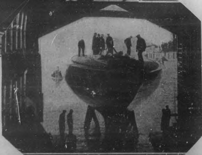
Uno de los buques de la armada inglesa en los momentos de emerger del agua, en virtud de la presión de aire producida en su escotadura, durante las prácticas realizadas para comprobar la utilidad de ese nuevo sistema ideado para resguardar la vida de los buques
